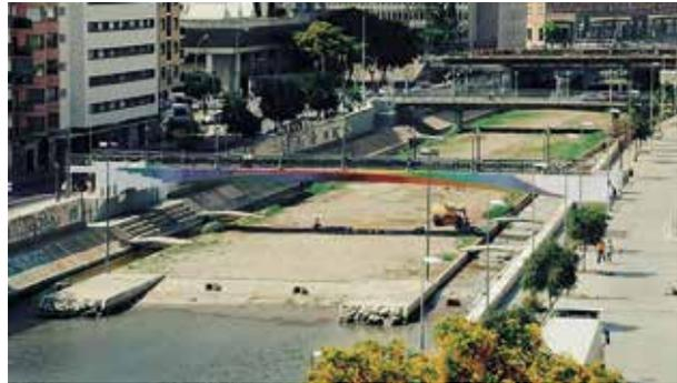
Esta pasarela peatonal formó parte del paquete de obras realizadas entre 1989 y 1993 a raíz del proyecto “recuperación para la ciudad de un espacio central: Guadalmedina”. Su estructura de hormigón armado salva la luz del cauce entre apoyos extremos. La necesidad de respetar la sección útil de desagüe prevista para avenidas extraordinarias obligó en su diseño a elevar el tablero sobre la rasante de la calle.
