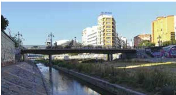
Puente de hormigón armado, está destinado fundamentalmente a mejorar la comunicación rodada entre ambas márgenes.
