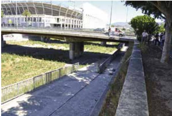
Construido con motivo del Campeonato Mundial de Fútbol de 1982, está formado por tableros de hormigón pretensado simplemente apoyados sobre pilas y estribos de forma continua, lo que permite a la estructura moverse libremente en caso de dilataciones térmicas o asentamientos diferenciales.
