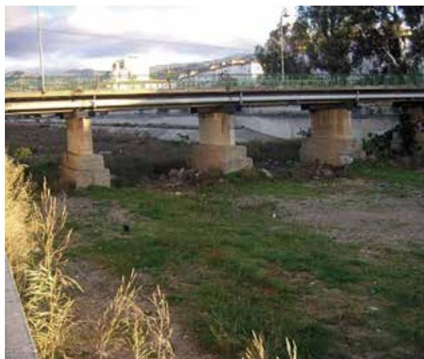
Es el decano de los puentes del norte de la ciudad. Consta de cinco apoyos intermedios compuestos por pilares de hormigón sobre basamento del mismo material y tablero de hormigón.
