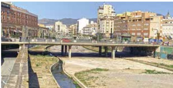
Concebido para descargar de tráfico al puente de Tetuán, consta de dos apoyos intermedios y estructura de hormigón armado; la estrechez de sus aceras obligó a destinar uno de los cuatro carriles de circulación a este fin.
