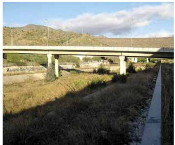
Sobre el Guadalmedina, se vislumbran una serie de puentes de hormigón armado resueltos con vigas prefabricadas de hormigón de sección continua, simplemente apoyadas, sobre dos apoyos intermedios. Son puentes de nueva construcción, bien resueltos, cuya belleza reside en su propia lógica estructural.
