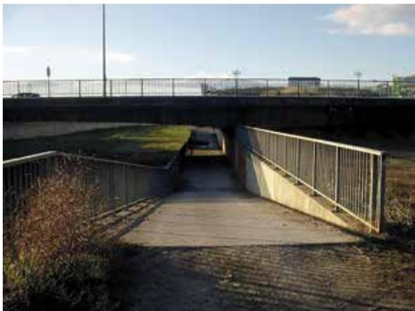
Construido para dar continuidad a la ronda intermedia de Málaga, soporta un importante paso de tráfico rodado. Su perfil bajo se explica por la anchura del cauce en este punto, por lo que no queda comprometida la sección de desagüe. Estructuralmente, está formado por vigas prefabricadas de hormigón armado y canto variable, simplemente apoyadas, sobre dos apoyos intermedios y capa de rodadura de asfalto sobre tablero de hormigón.
