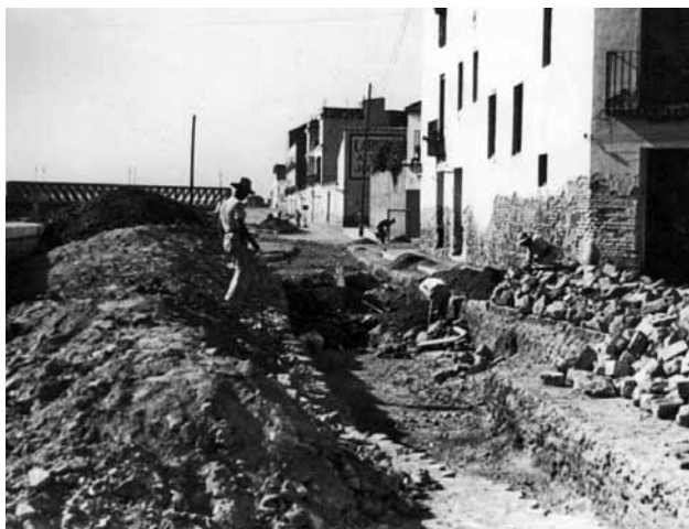
Colector margen derecho. Pasillo Sta. Isabel 1950.
