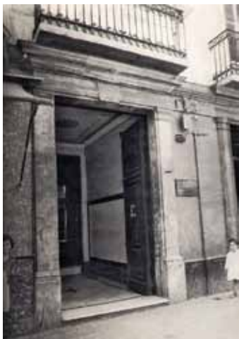
Fachada en Carretera 31 con señal de donde llegó el agua en 1907.
