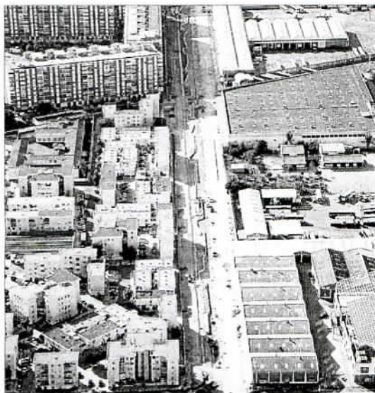
Vista del avance de las obras del bulevar sobre las vías del AVE. (IMAI)
