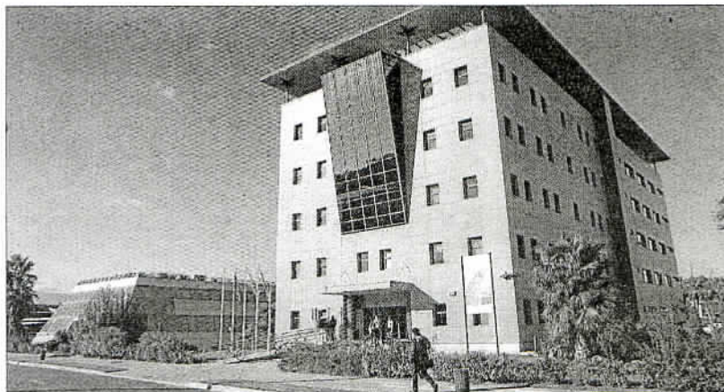
Edificio en el que se encuentra la OTRI. ARONIEGA
