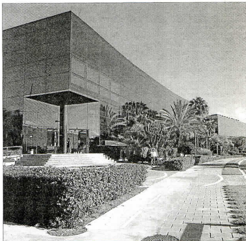
Vista del PTA. GREGORIO TORRES
