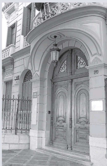
Palacio de la Tinta, que pertenece a la Junta. :: ALVARO LÓPEZ
