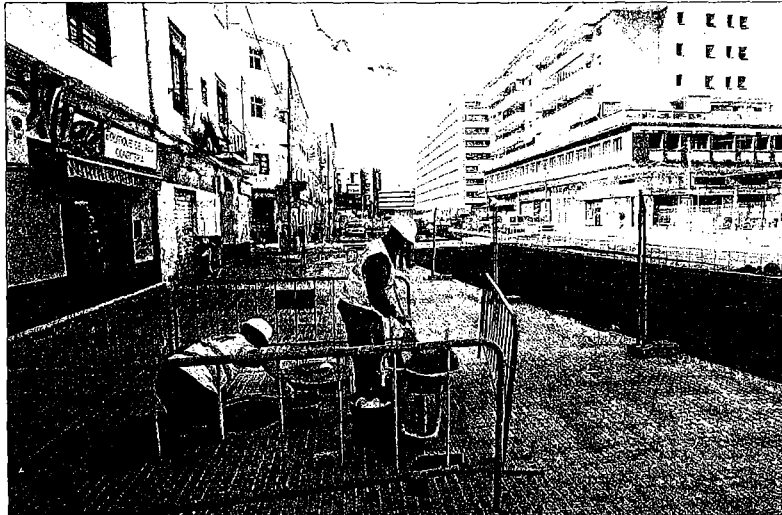
Operarios trabajan en las obras del metro a su paso por los Callejones del Perchel. ARCINIEGA
