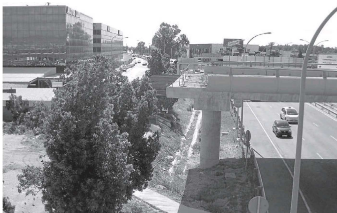
Situación del último viaducto pendiente para completar el Acceso Sur al aeropuerto. :: MORENO
