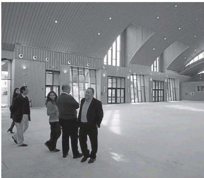
Las autoridades locales en una visita al edificio en obras. :: M. C. J.
