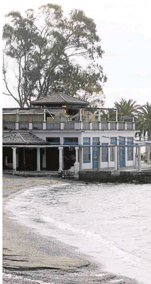
Estado actual de los Baños del Carmen. :: SUR. ARCHIVO
