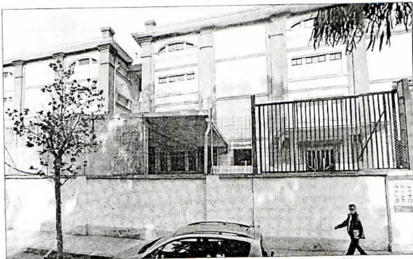
Vista de los edificios de los antiguos secaderos de Tabacalera, donde irá el Centro Tecnológico.
