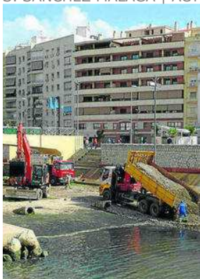
Obras en el cauce del río.
