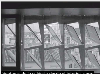
Ventanas de la cubierta desde el interior. :: SUR
