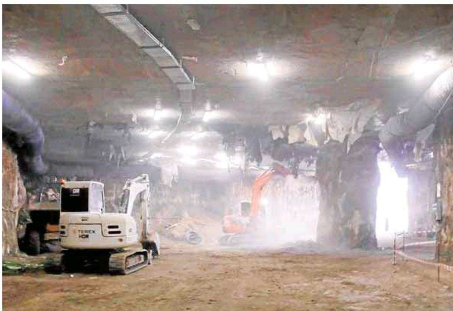
Excavación entre pantallas bajo Callejones del Perchel durante el pasado mes de julio. :: sur
