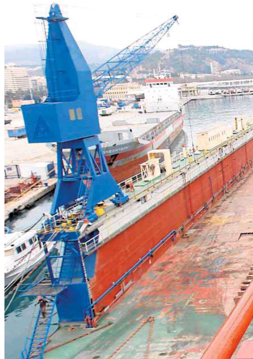
Mario López, en la nueva grúa de 50 metros de altura que permitirá
