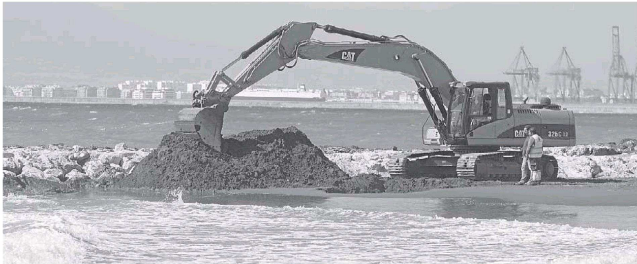
Trabajos para la retirada de la arena sobrante, ayer en las playas de El Palo. :: ÁLVARO CABRERA
