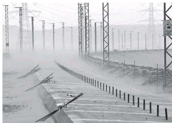
Se han montado placas de vías para evitar daños por la arena. :: ADIF
