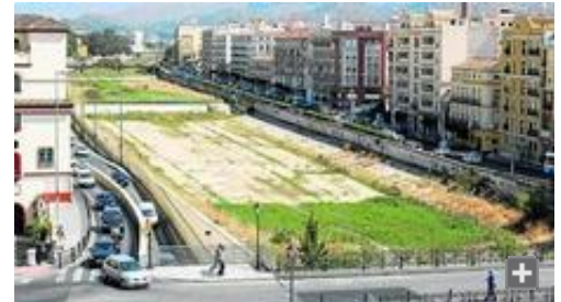
Imagen del cauce urbano del río Guadalmedina, a la altura del puente de la Aurora.
