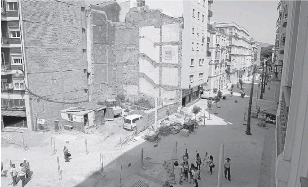
La reformada zona que albergará el Soho empieza a cobrar forma. :: SALVADOR SALAS
