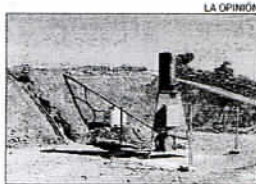
DES GASIFICACIÓN Nuevos pozos
