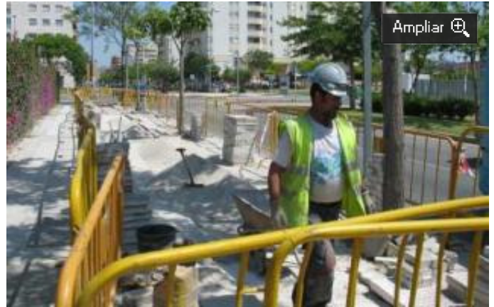
Los trabajos de conexión del suministro eléctrico han comenzado en Teatinos.
