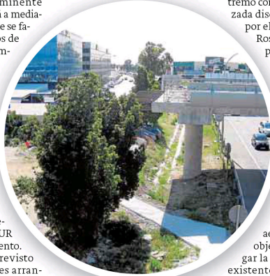
El viaducto que falta por acabar, cerca de la terminal T-3.
