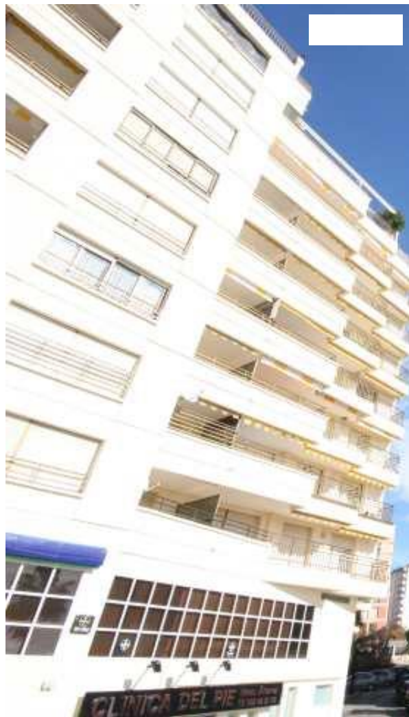
Imagen de un edificio del centro de Marbella. L.O.
