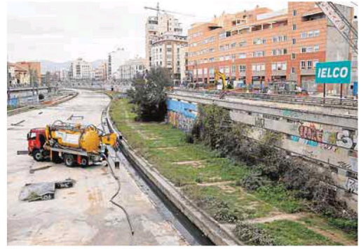
Operarios de Emasa trabajaban ayer para limpiar el cauce. :: NITO SALAS
