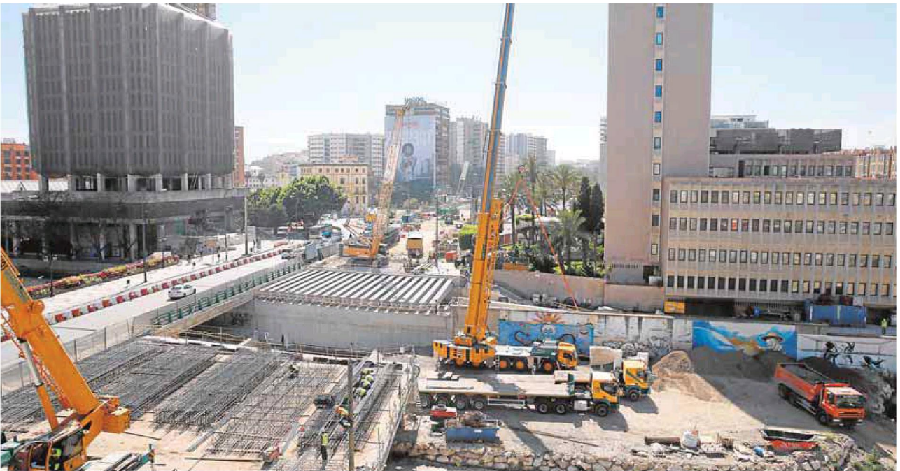
Obras para reponer el tablero del puente de Tetuán, que se reabrirá al tráfico en las próximas semanas. :: SALVADOR SALAS
