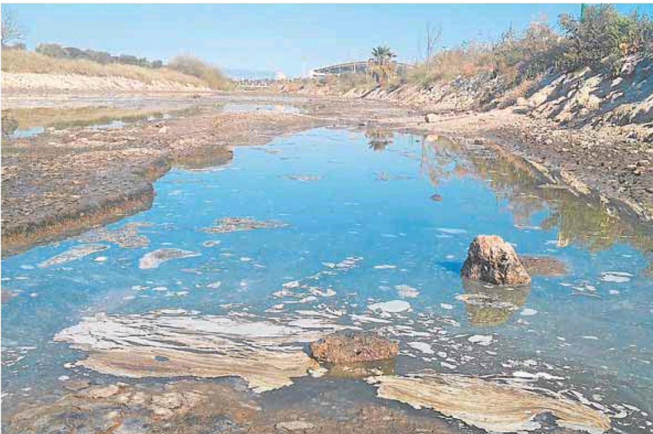
El hedor procedente de las aguas estancadas en el canal de pluviales se extiende por toda la zona. :: F. J.
