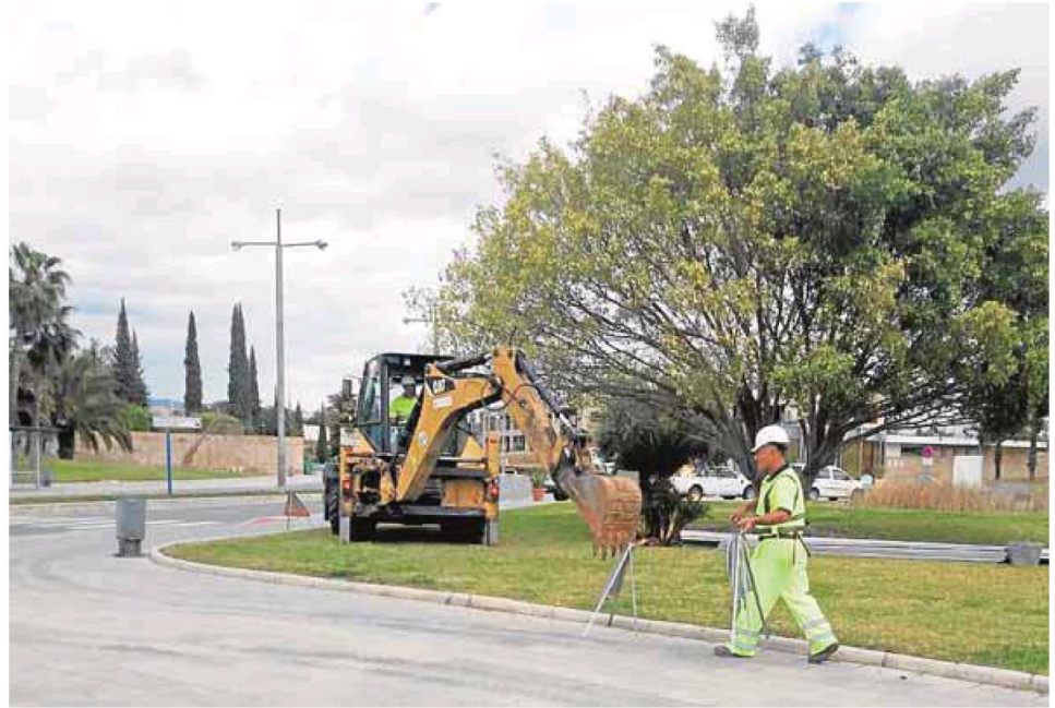
Obras en la glorieta de acceso al PTA para habilitar un tercer carril. :: SUR
