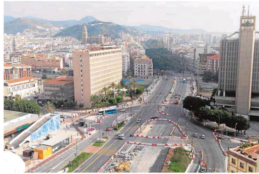
Vista aérea de la zona de obras del metro en la avenida de Andalucía, que está parada. :: MORENO
