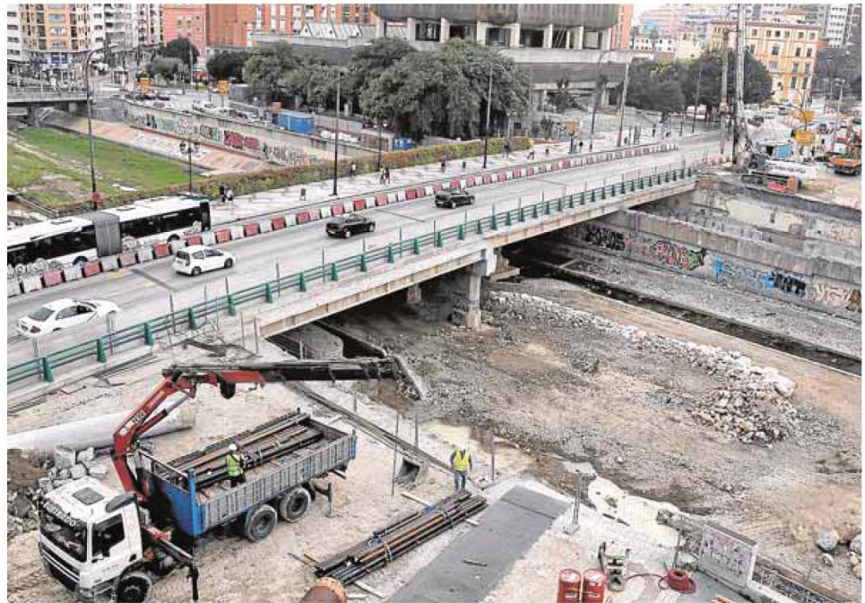
Obras del metro para atravesar soterrado el cauce del Guadalmedina. :: NIÑO SALAS
