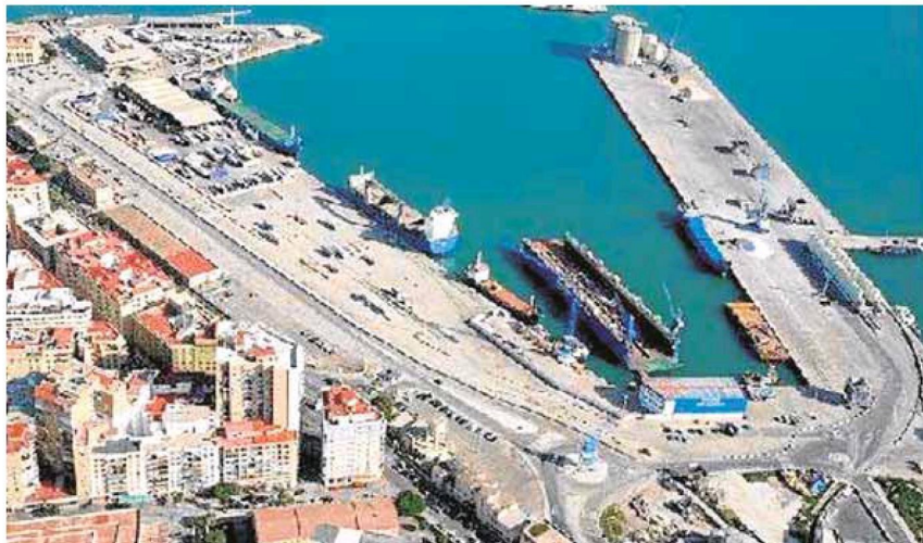
Zona en la que está prevista la instalación del centro comercial. :: A. CABRERA
