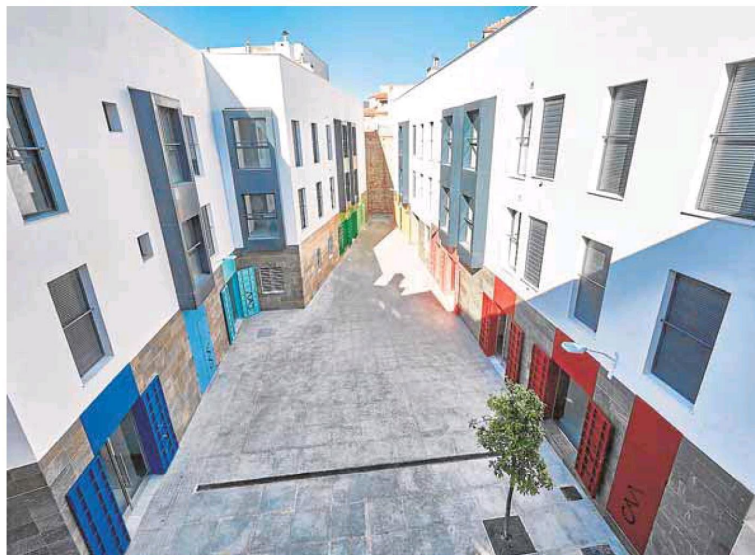
Aspecto de la nueva plaza entre Muro de las Catalinas y Andrés Pérez. :: OMAU-AYTO. DE MÁLAGA
