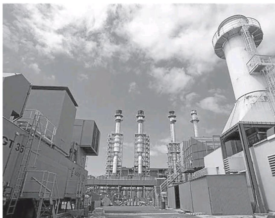
Central de ciclo combinado en Fuerteventura (Canarias). :: r. c.
