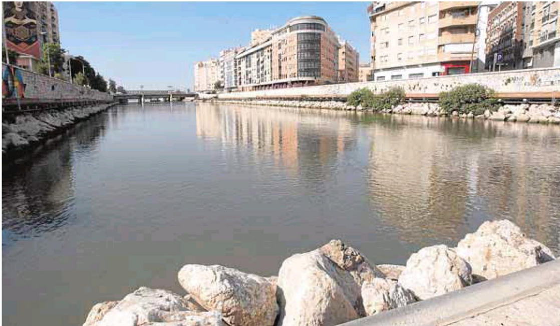
Zona del Guadalmedina en la que intervendrá Emasa a partir de este lunes. :: ÁLVARO CABRERA
