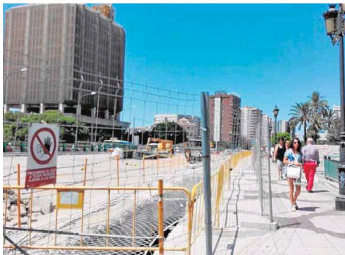
Estado de las obras previas a la demolición del lateral norte del puente de Tetuán. :: MORENO
