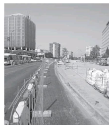
Obras en el puente. :: sur
