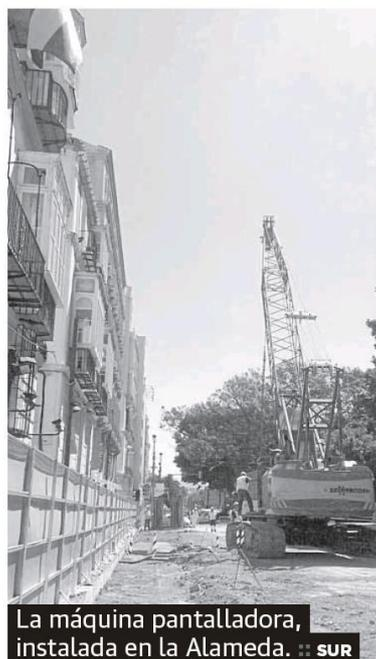
La máquina pantalladora, instalada en la Alameda. :: SUR
