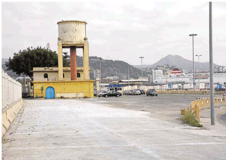
Zona del muelle cuatro en donde se levantaría el nuevo centro comercial del Puerto. :: FRANCIS SILVA
