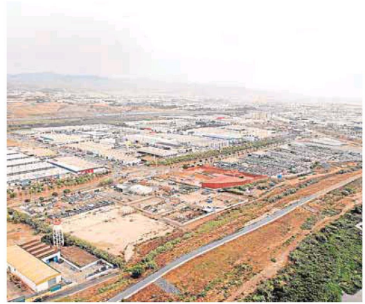
Vista aérea del polígono Guadalhorce. :: SALVADOR SALAS
