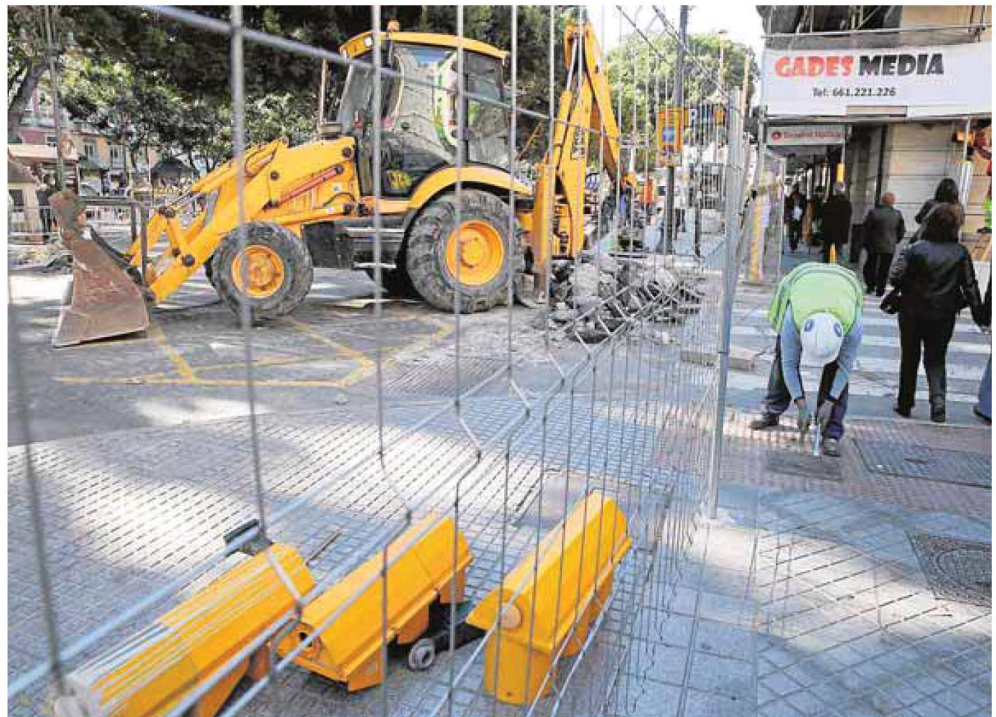
Obreros del metro en los trabajos en la Alameda Principal. :: SALVADOR SALAS
