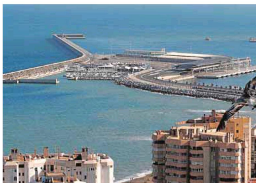
Dique de Levante, en el que se construirá el hotel. :: ÁLVARO CABRERA
