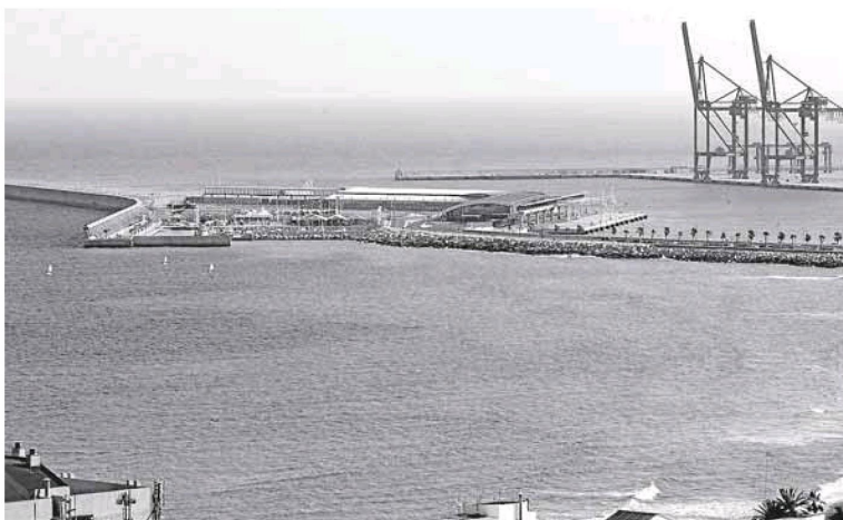
El hotel de lujo se levantará en la explanada existente en el dique de Levante. :: A. CABRERA
