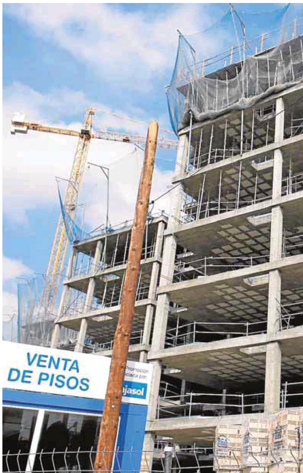
Bloque de pisos en construcción. :: SUR
