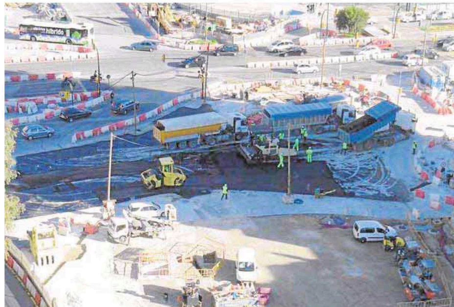
Obras del suburbano en la avenida de Andalucía. :: sur
