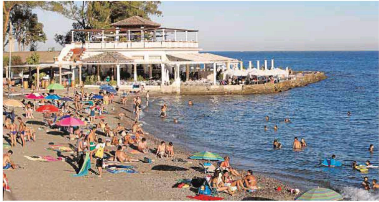
La playa de los Baños del Carmen multiplicará su anchura y su longitud tras las obras. :: ÑITO SALAS
