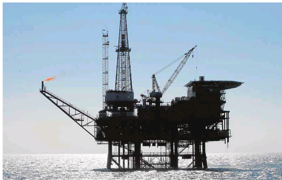
Una de las plataformas de perforación utilizada por Repsol para las prospecciones. :: SUR
