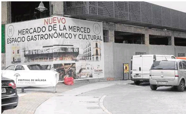
La plaza de abastos permanece cerrada por obras desde mediados de marzo. :: SUR
