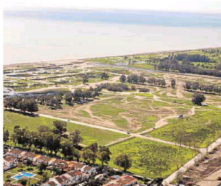
Terrenos de Arraijnal, donde irá un parque y La Academia. :: SUR
