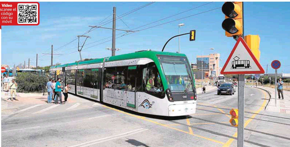
Un convoy del metro atraviesa por primera vez el cruce del Hospital Clínico, en Teatinos, regulado con semáforos especiales. :: SALVADOR SALAS
