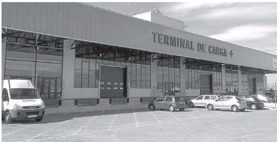
En la terminal de carga del aeropuerto de Málaga trabajan actualmente 17 empresa. :: sur
