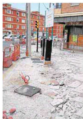
Tramo en obras en la avenida Juan XXIII. :: SALVADOR SALAS
